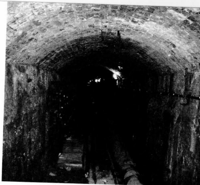
Sztolnia Gertrudy - widoczny system instalacji wodnej dla celów przemysłowych Zakładów w Złotym Stoku - obecnie początkowy odcinek muzeum górnictwa złota.
