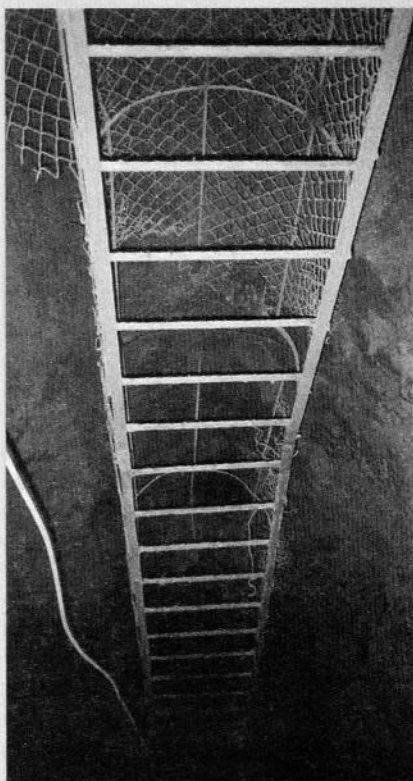
Drabina stalowa o 150 szczeblach, długość drabiny 45 m (11 pięter).
