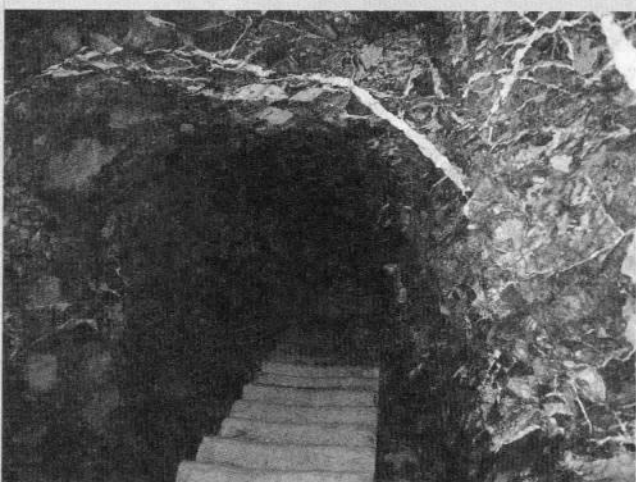
Betonowe schody z poziomu III na II - stan istniejący.
