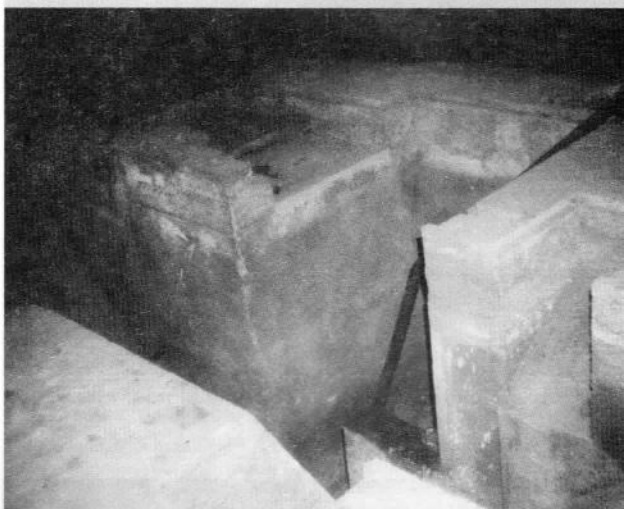
Głęboki fundament betonowy w części hali, gdzie stały urządzenia i maszyny.
