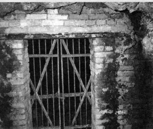
Dno szybu z drabiną - stalowa brama do betonowo-ceglanego korytarza.
