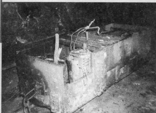
Elektrowóz przy pomieszczeniu maszynowni na poziomie III - stan z 1988 roku.
