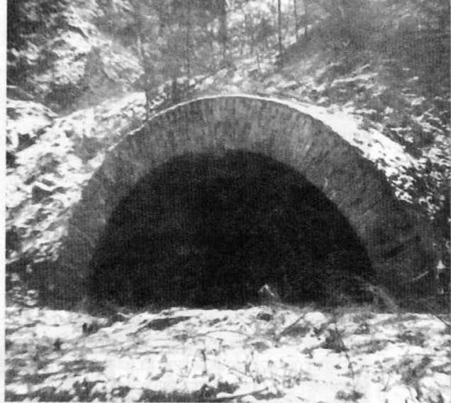
Nieistniejące już wejście do kopalni na poziomie II – część zakładu zbrojeniowego – tunel miał 20 m długości, był wysoki na 2,5 m, szeroki na 3,5 m. Stan z 1988 r.
