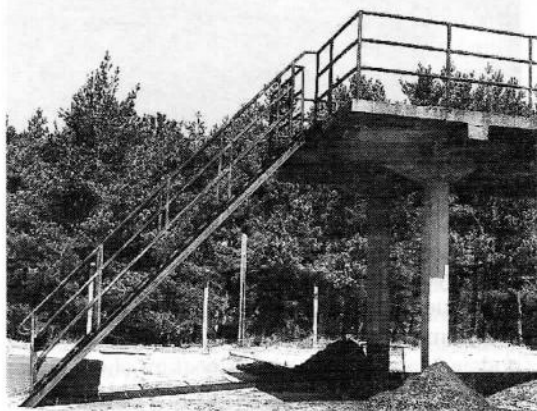
Współczesna pochylnia zbudowana na dachu bunkra
