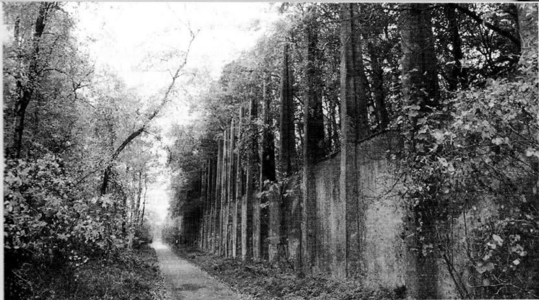
Mur z żelbetonu
