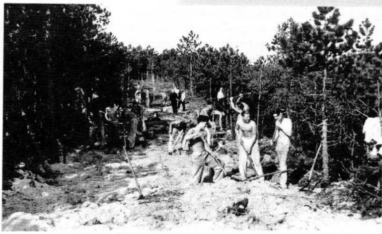
Fot. 2 - Budowa drogi do wyrzutni nr 1.
