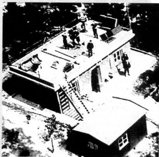
Fot. 6 - Widok na stanowisko dowodzenia nr 1.
