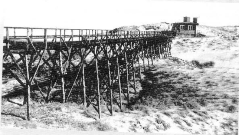
Fot. 3 - Konstrukcja mostu do stanowiska obserwacyjnego nr 3.
