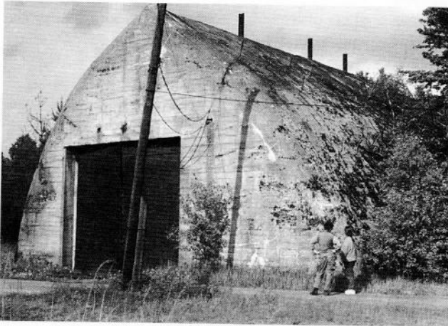
Schron kolejowy - widok od strony wjazdu pociągu. Na szczycie widoczne belki do mocowania drzew i siatek maskujących.
