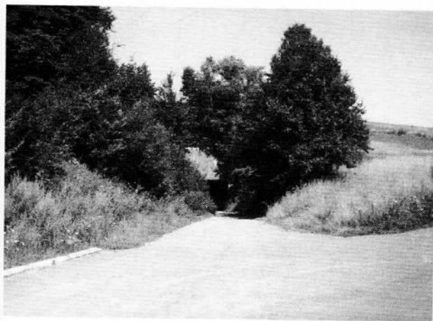
Wjazd do tunelu pod Żarnowską Górą w Strzyżowie, od strony stacji PKP.
