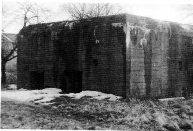
Białobrzegi - schron stacji i ujęcia wody.
