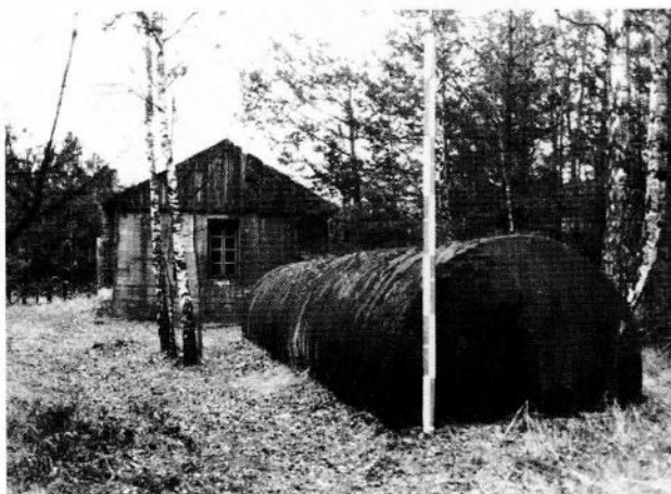
Zbiornik na paliwa płynne.
